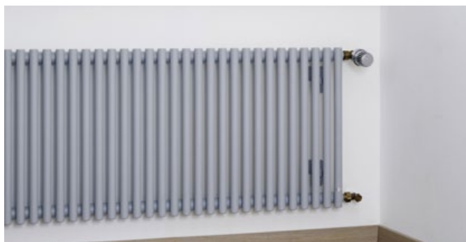
Krera 2-reihig, 500 x 2933 (77 EL) mm im Farbton Lichtgrau samt matt (Nr. 8N). Modernisierung an vorhandenen Anschlüssen.
