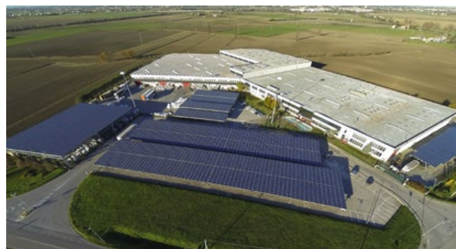
Produktionsstätte mit Blick auf die Photovoltaikanlage
