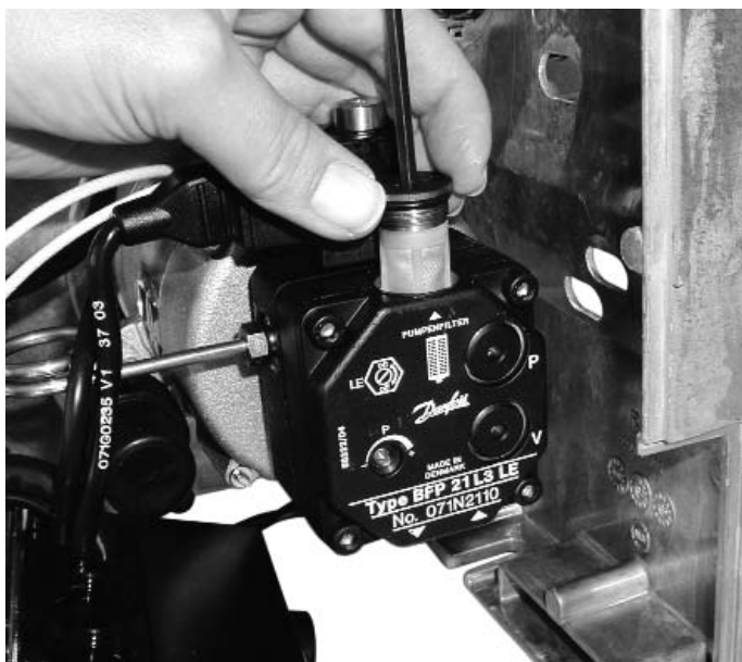
Abbildung 27 - Ausbau des Ölfilters Figure 27 - Disassembly of the oil filter - Démontage du filtre à fioul
